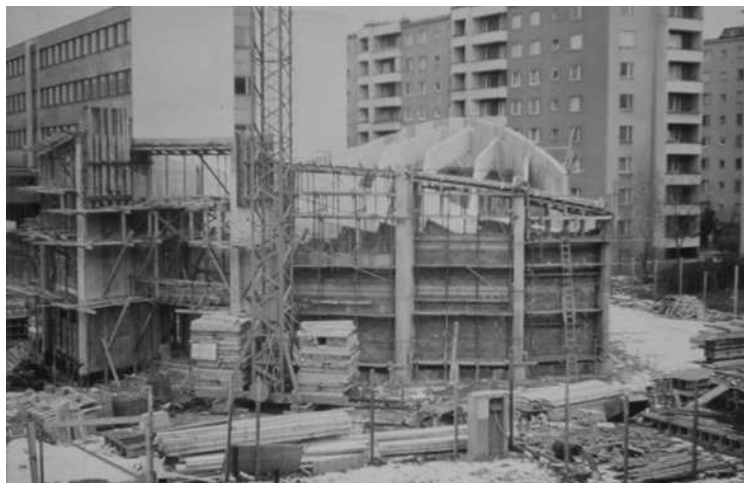
Baustand der Kirche im März 1983
